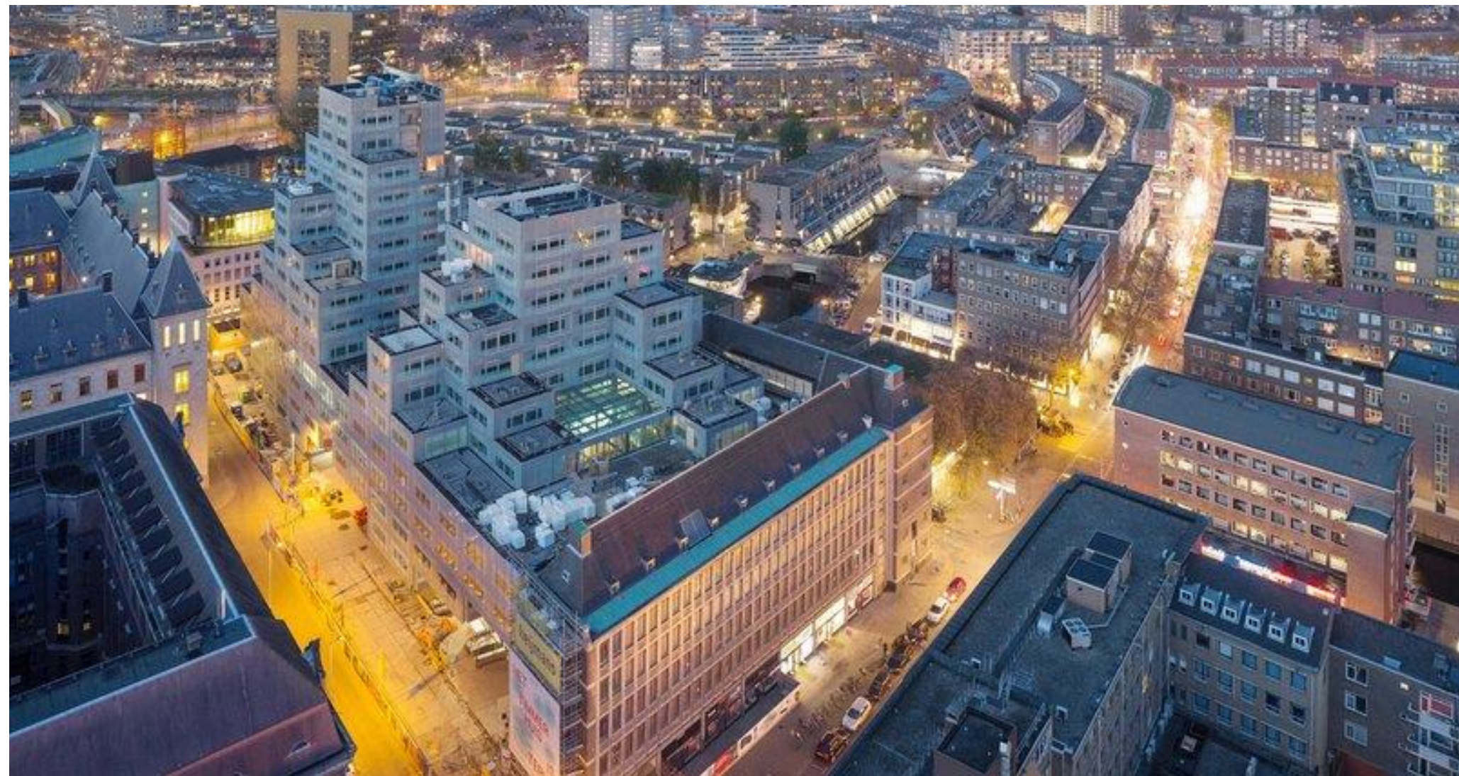
Completion Timmerhuis Rotterdam
